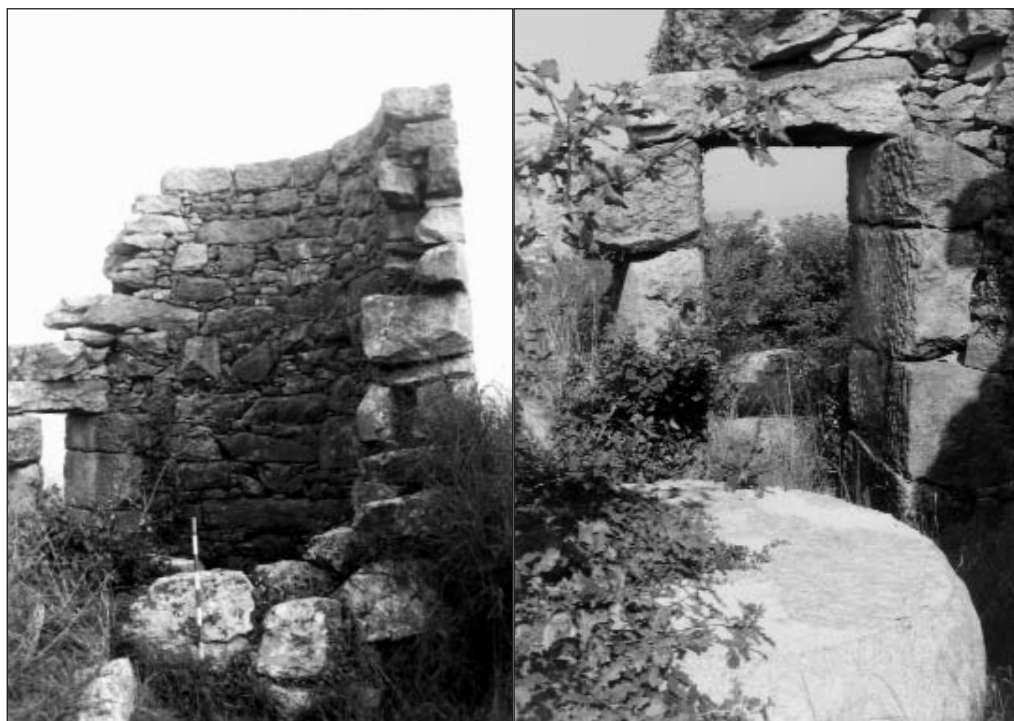
O muíño de vento de Navia, interior. Restos da torre, detalle da porta e pedra do inxenio para triturar gran..
